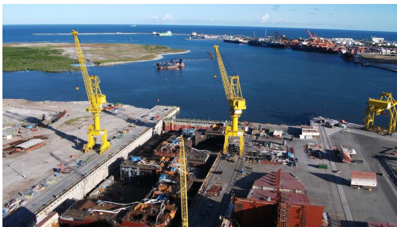
Estaleiro - Porto de Suape (PE) - 2011
